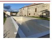
termoestable y elastómera (flexible y elástica, con gran capacidad de puentear las posibles fisuras del soporte). La membrana cura en pocos segundos y puede entrar en servicio en pocas horas.
